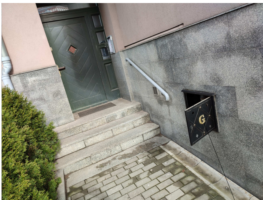
Istniejąca skrzynka gazowa o wym. 450x400x250 z proj. GKG dn50 kołnierzanym
