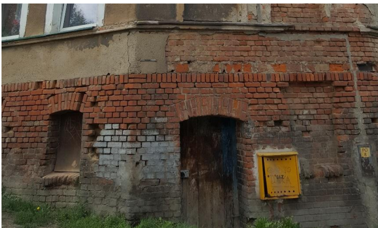
Fot. 2 Elewacja frontowa - ubytki cegieł w cokole oraz spoin między cegłami.
