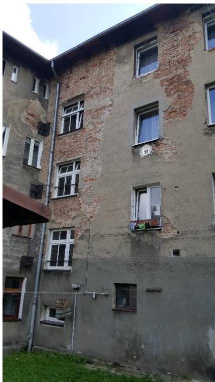
Fot. 1 Elewacja tylna - ubytki tynku, zawilgocenie.
